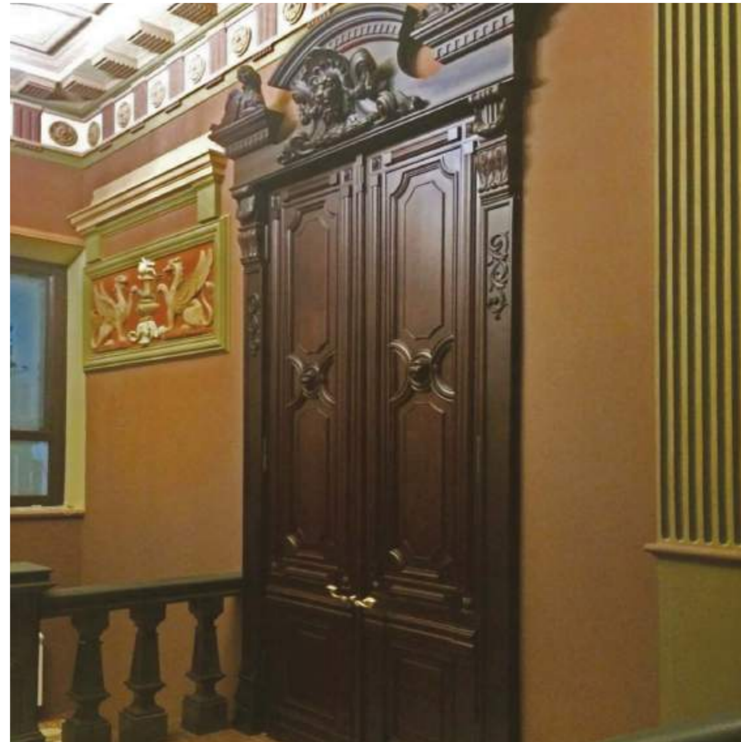
Особняк Я.А. Река «Дом со львами» > двери (реставрация). Материал > МДФ, шпон дуба, массив дуба | Покрытие > тонировка и лак Mansion J. A. Recca «House with lions» > doors (restoration). Material > MDF, oak veneer, solid oak | Finishing > stain, lacquer
