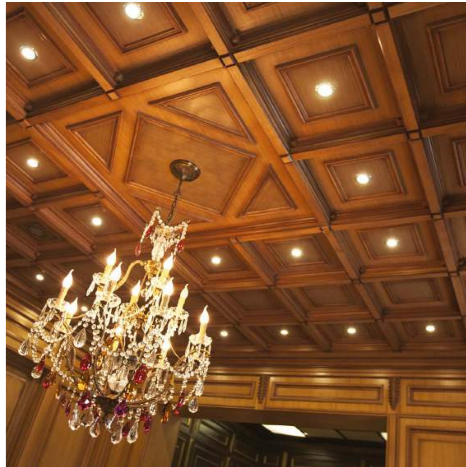
161 Частный интерьер > стеновые панели, кессонный потолок, двери. Материал > МДФ, шпон дуба, массив дуба | Покрытие > тонировка, лак Residential interior > wall panels, caisson ceiling, doors. Material > MDF, oak veneer, solid oak | Finishing > stain, lacquer
